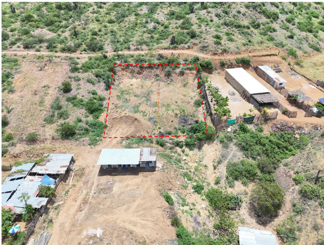
Foto 8: Vista sureste -noroeste de la remoción superficial de dos áreas (líneas rojas) con cerco perimétrico para lotización de terrenos (Afectación 6).
