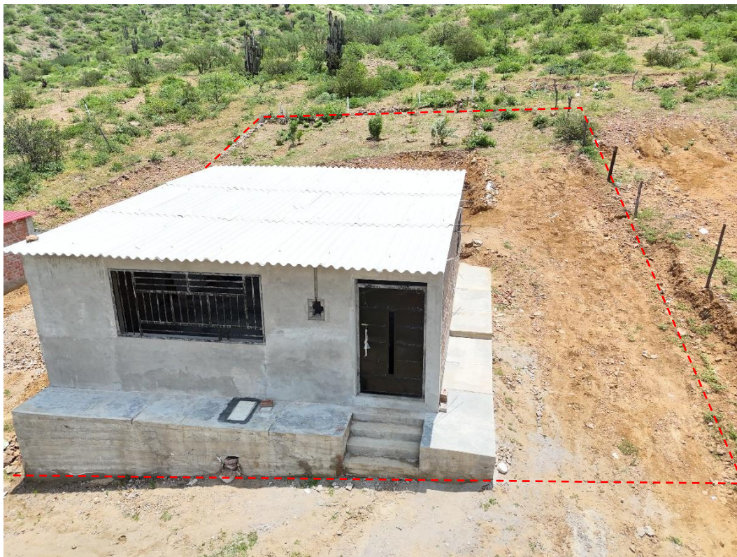
Foto 6: Vista sureste -noroeste de la remoción y excavación del área para el acondicionamiento e instalación de un asentamiento de material noble (Afectación 4).
