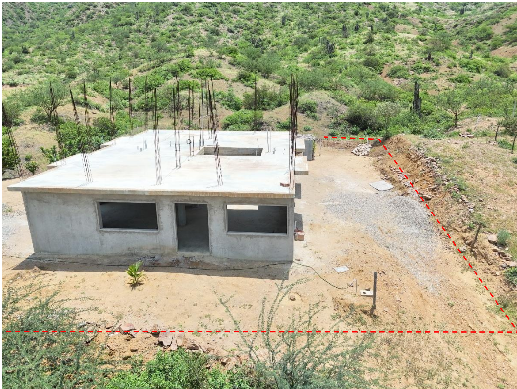
Foto 3: Vista sureste -noroeste de la remoción y excavación del área para el acondicionamiento e instalación de un asentamiento de material noble (Afectación 1).
