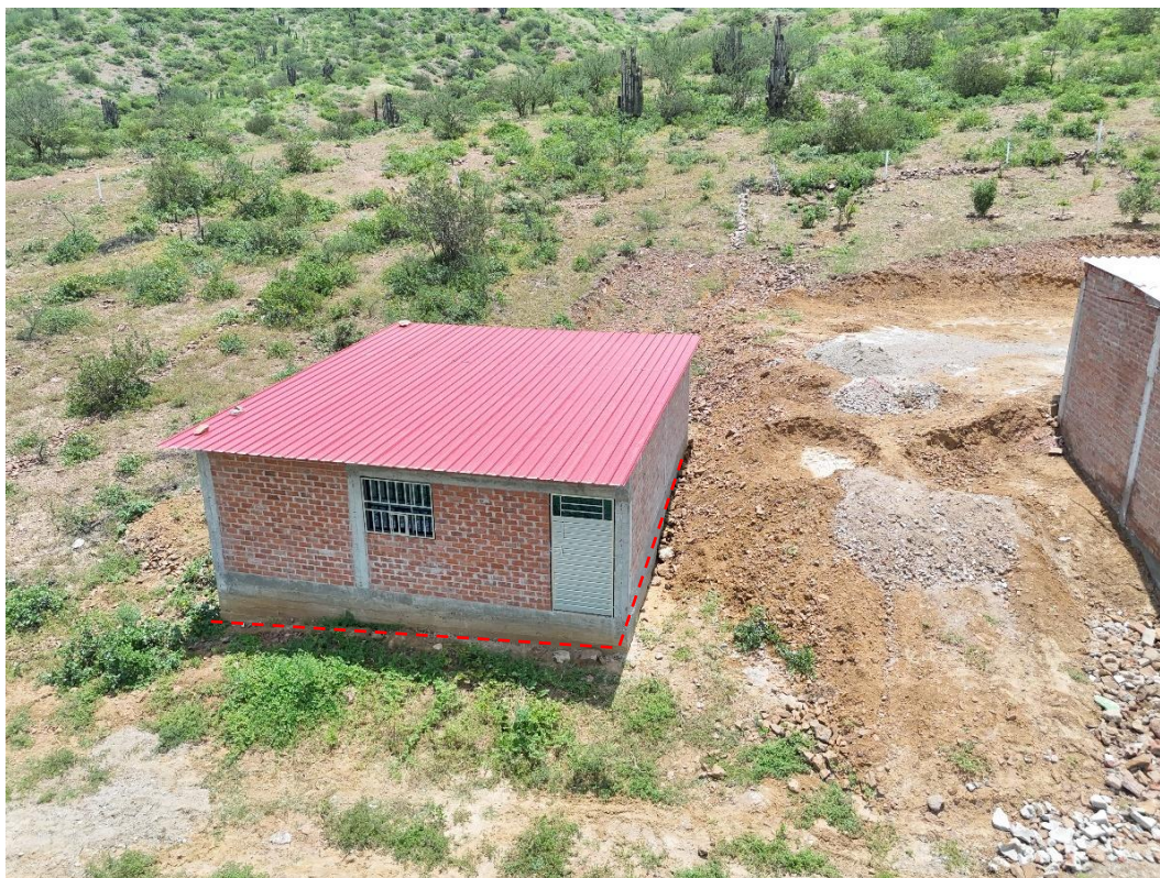
Foto 5: Vista sureste -noroeste de la edificación de un asentamiento de material noble donde ha implicado trabajos de excavación y remoción del área (Afectación 3).
