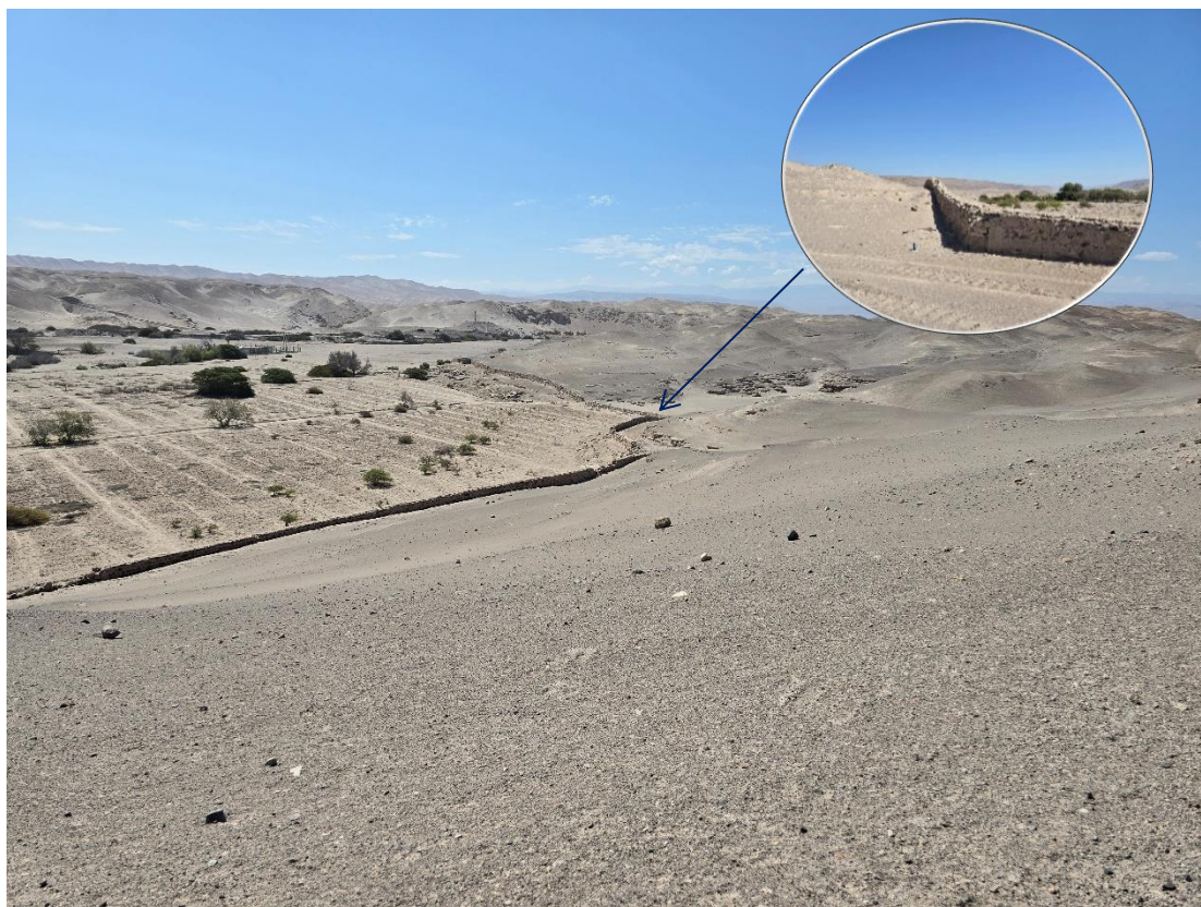
Fotografía 4: vista de muro perimétrico que se encuentra colindante.
