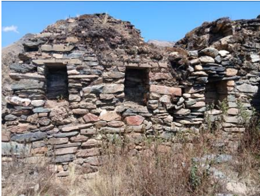
Imagen N° 6: Vista en detalle de hornacina al interior de estructuras.
