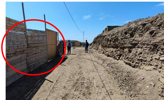
Imagen tomada durante la inspección de fecha 09.04.2024
