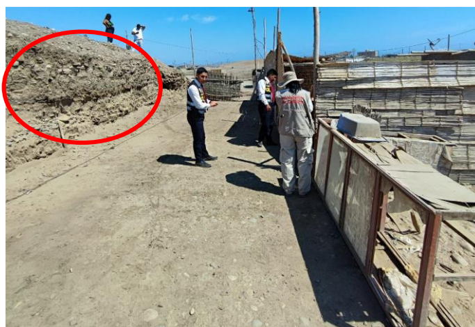
Imagen tomada durante la inspección de fecha 09.04.2024
