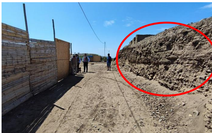
Imagen tomada durante la inspección de fecha 09.04.2024
