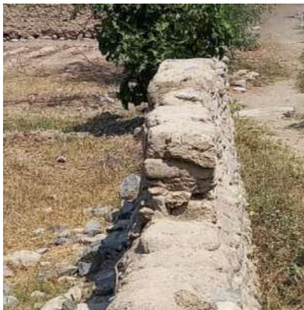
Foto 04: Detalle del muro prehispánico en cuestión, toma de sur a norte, y los elementos arquitectónicos que lo componen, piedras, adobes y argamasa de barro. Registro del 15.12.2023.
