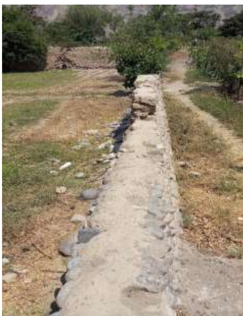
Foto 03: Vista del muro prehispánico en cuestión, toma de sur a norte, obtenido de la base de fotografías de la Dirección de Control y Supervisión. Registro del 15.12.2023.
