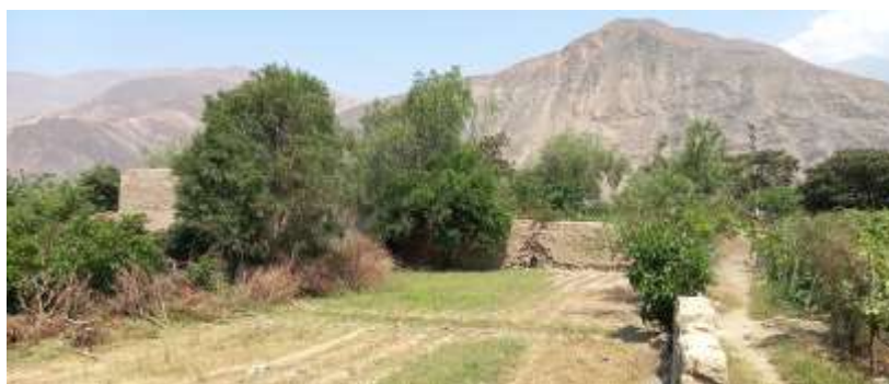
Foto 02: Vista del muro
