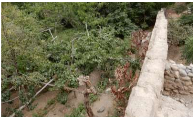
Foto 05: Vista de dos elementos arquitectónicos que conforman el sitio arqueológico, manteniendo la técnica y elementos constructivos (base de piedras con argamasa de barro y adobes en la parte superior) como se registró el elemento destruido en su última foto del 2023.
