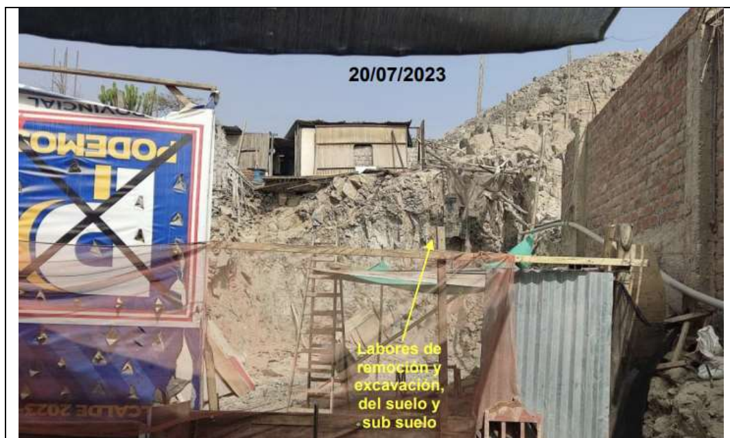
Foto 2. Sitio arqueológico Huaycán Alto – Río Seco, Parcela A. Vista panorámica de las labores de excavación y remoción del suelo y subsuelo, se ubica al interior de la poligonal intangible. Foto tomada el 20 de julio de 2023.
