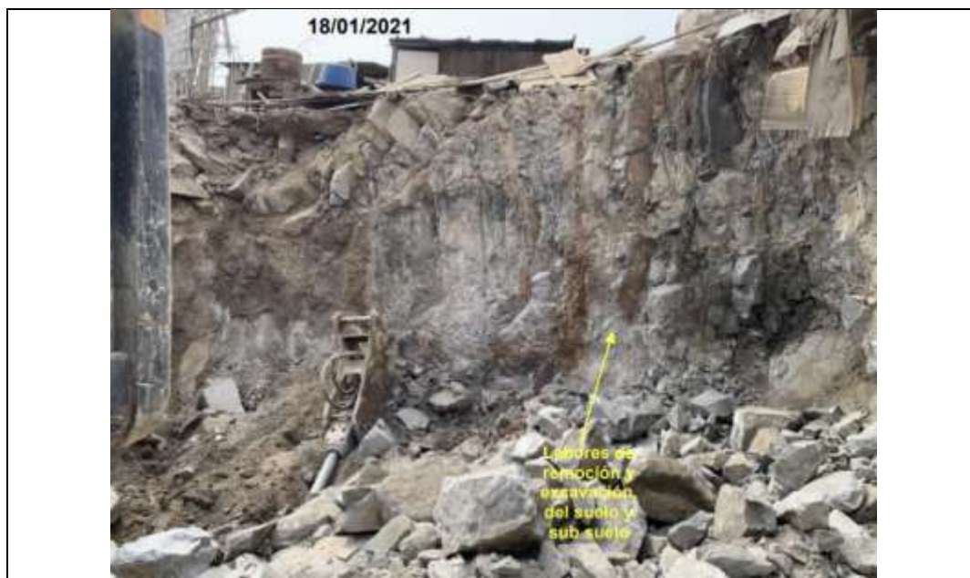
Foto 1. Sitio arqueológico Huaycán Alto – Río Seco, Parcela A. Vista panorámica de las labores de excavación y remoción del suelo y subsuelo, se ubica al interior de la poligonal intangible. Foto tomada el 18 de enero de 2021.
