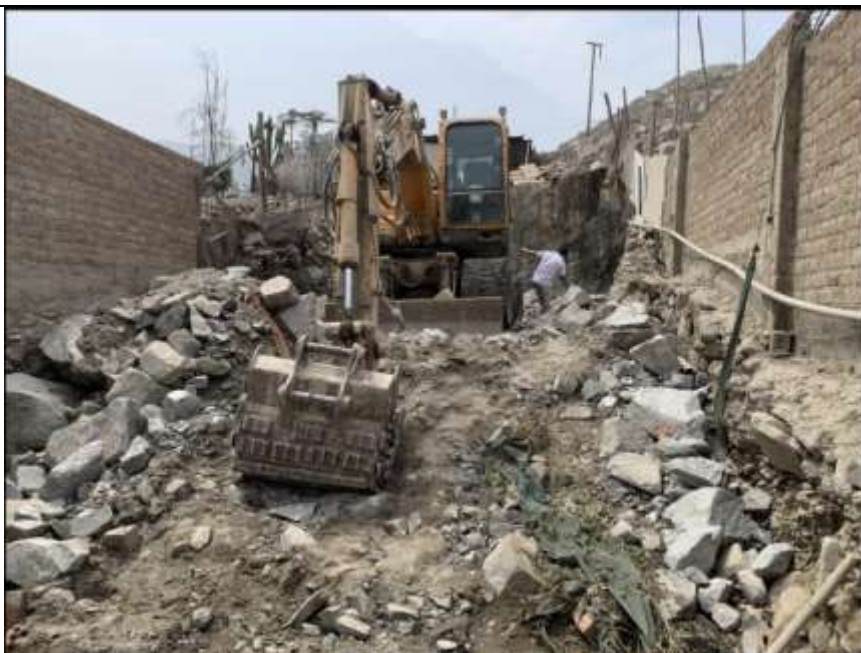
Foto 3. Vista panorámica donde se verifico la maquinaria pesada (retroexcavadora) en ejecución, donde se realizaron trabajos de excavación y remoción del terreno al interior del área intangible.
