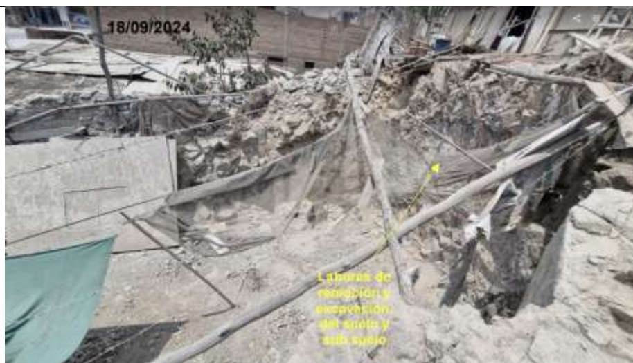
Foto 4. Sitio arqueológico Huaycán Alto – Río Seco, Parcela A. Vista panorámica de las labores de excavación y remoción del suelo y subsuelo, se ubica al interior de la poligonal intangible. Foto tomada el 18 de septiembre de 2024.
