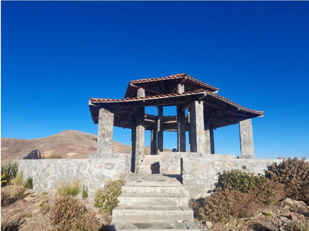
*Fotografía 9. Vista detalle de la construcción del mirador realizado con las piedras canteadas de origen arqueológico, efectuadas sobre las evidencias arqueológicas (Vista NO-SE).*
