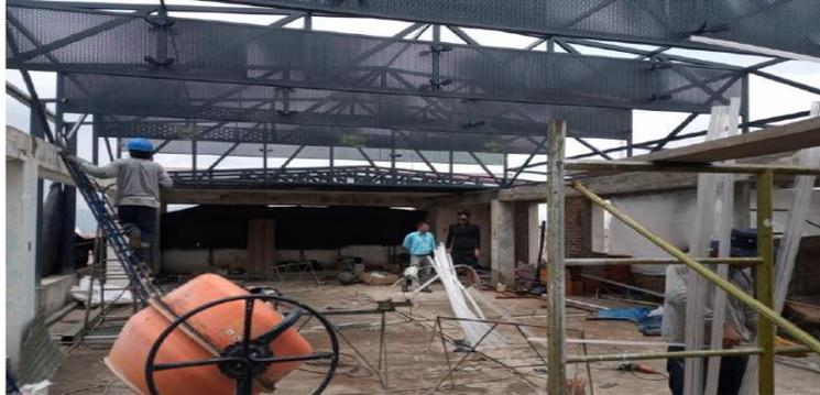
**Imagen del 16.03.23, donde se aprecian enchapes, la sobrecarga vaciada y algunas obras de drywall**
