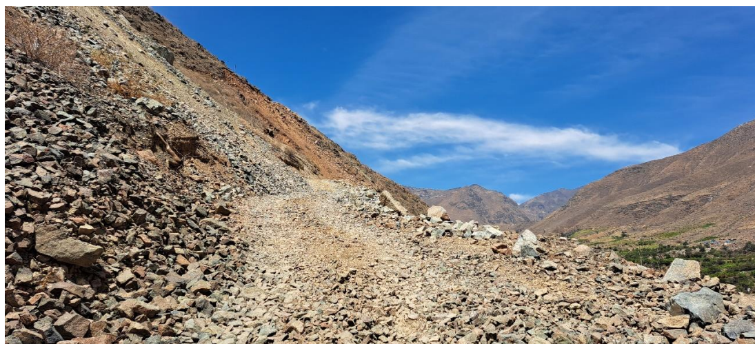
Imagen 10. Vista general de la trocha clandestina aperturada sobre el Sitio arqueológico de Chapas (vista O-E).
