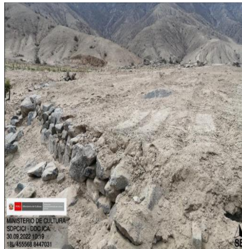
Imagen N° 02: Vista del área afectada y andenería removida, fotografiada el 30 de setiembre de 2022 - fuente Informe técnico N° 007-2022-SDPCIC-BHEP/MC.
