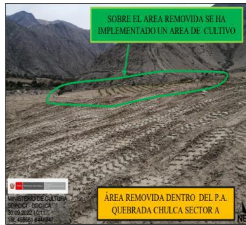
Imagen N° 01: Vista del área afectada, fotografiada el 30 de setiembre de 2022 - fuente Informe técnico N° 007-2022-SDPCIC-BHEP/MC.
