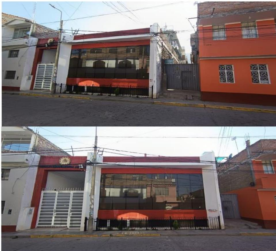
**Figura 07, Figura 08/ Fuente:** Se visualiza una edificación que tiene un semisótano y un primer piso con losa aligerada horizontal y la azotea presenta parapetos en el límite de la azotea / Inspección realizada por personal de la DDC Ayacucho el 17-06-2024
