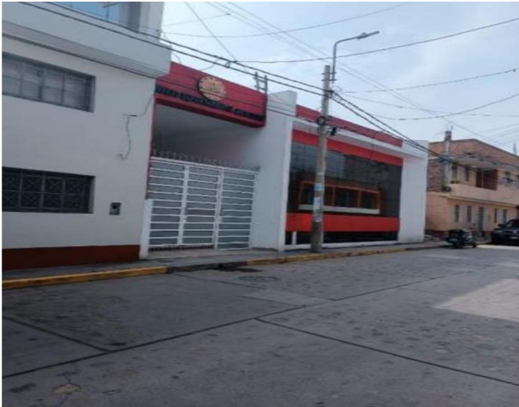
**Figura 06/ Fuente:** se visualiza la fachada del bien inmueble el cual presenta muros de albañilería con mortero de cemento y losa aligerada horizontal del primer piso; que, se encuentra revestido con pintura de color rojo y blanco, así como la presencia de un portón pintado de blanco y vidrios, asimismo se visualiza el retiro que presenta en la zona de fachada aproximadamente de 0.80 m / inspección realizada por personal técnico de la DDC Ayacucho el 09-03-2023.
