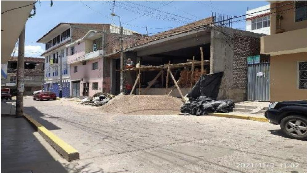
**Figura 04/ Fuente:** en la imagen se visualiza que la edificación del sótano y primer piso se ha culminado y se encuentra a nivel de casco, se ve que se ha armado unos acros con estructuras de madera con la finalidad de que el personal realice el enlucido de los muros interiores, se ve la presencia de material de construcción como agregados, ladrillos, así como personal trabajando en plena obra. /inspección realizada por personal técnico y legal de la DDC Ayacucho el 09-11-2022.
