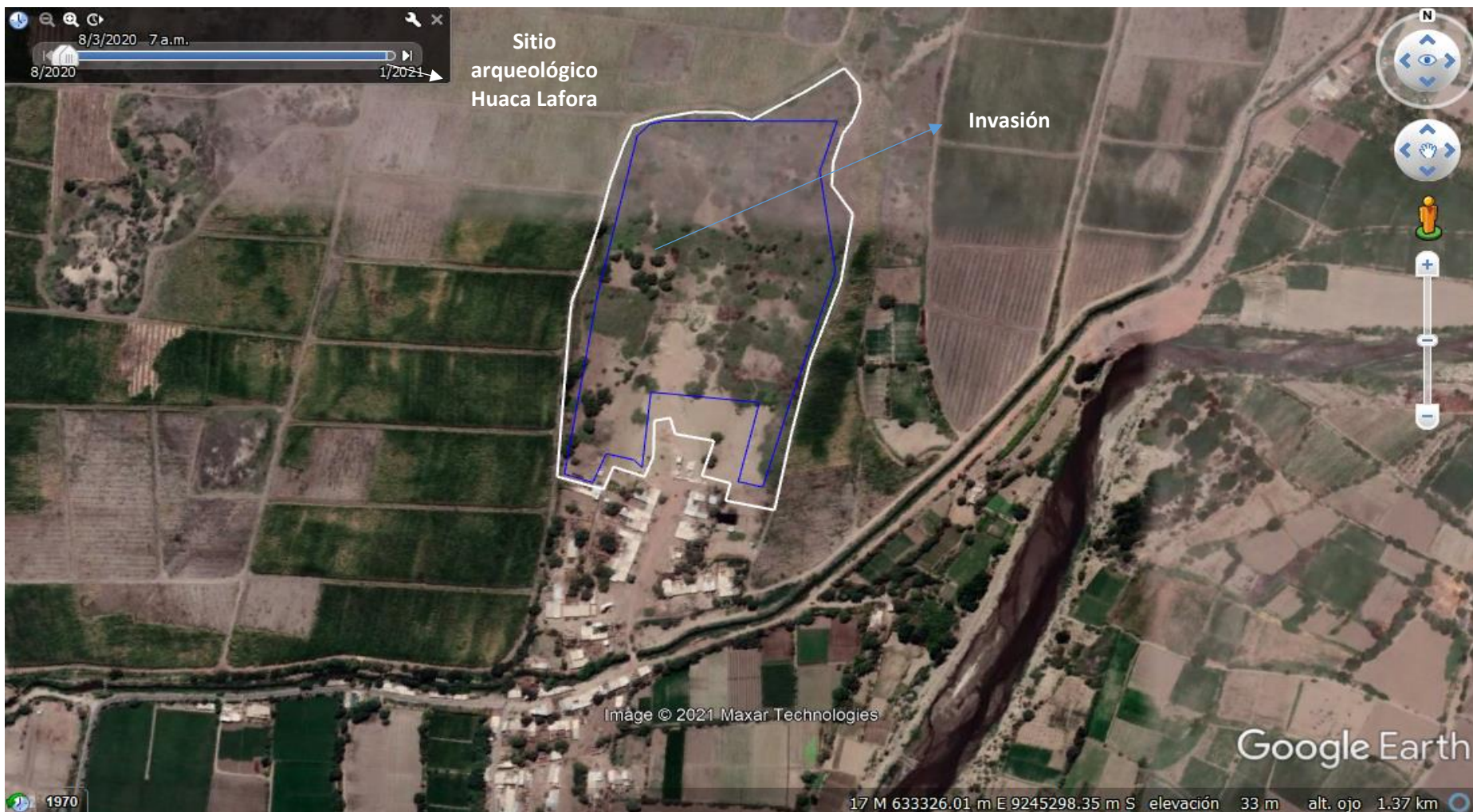
Imagen 02: Ubicación de la afectación (invasión; polígono azul) dentro del sitio arqueológico Huaca Lafora (polígono blanco).
