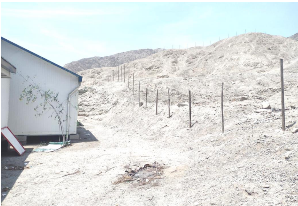
Foto 2: corte del talud para la construcción de aulas en módulos prefabricados y cerco de palos.
