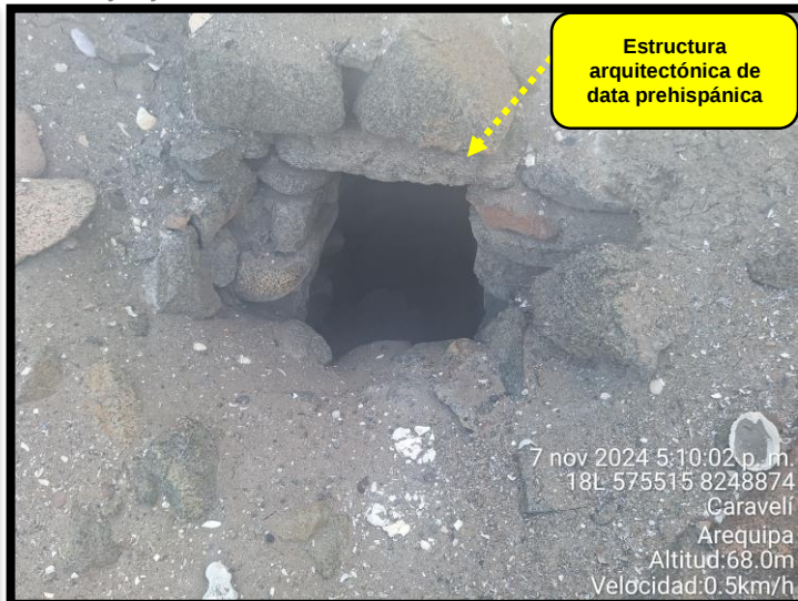
Foto N° 02: correspondiente al mes de noviembre del 2024, en el que se visualiza una estructura arquitectónica en regular estado de conservación.
