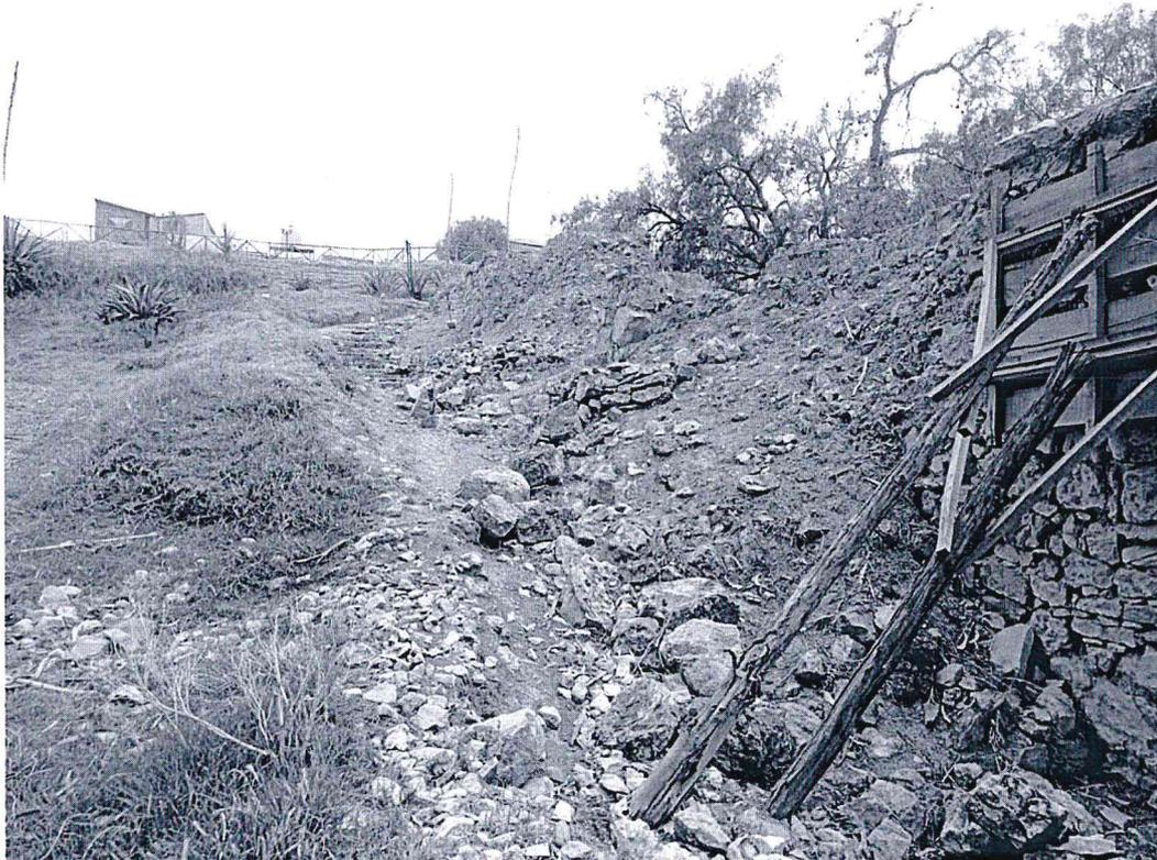
Foto 7. Muros en proceso de colapso las cuales requieren apuntalamiento como medidas preventivas.
