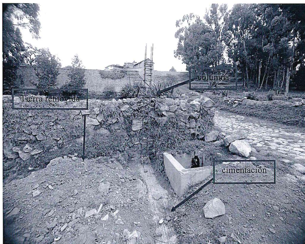
Foto. 3: vista de la afectación directa al interior del polígono de delimitación donde se evidencia cimentación de columna de fierro, así misma tierra removida de la zanja excavado. (inspección 05/10/2024).
