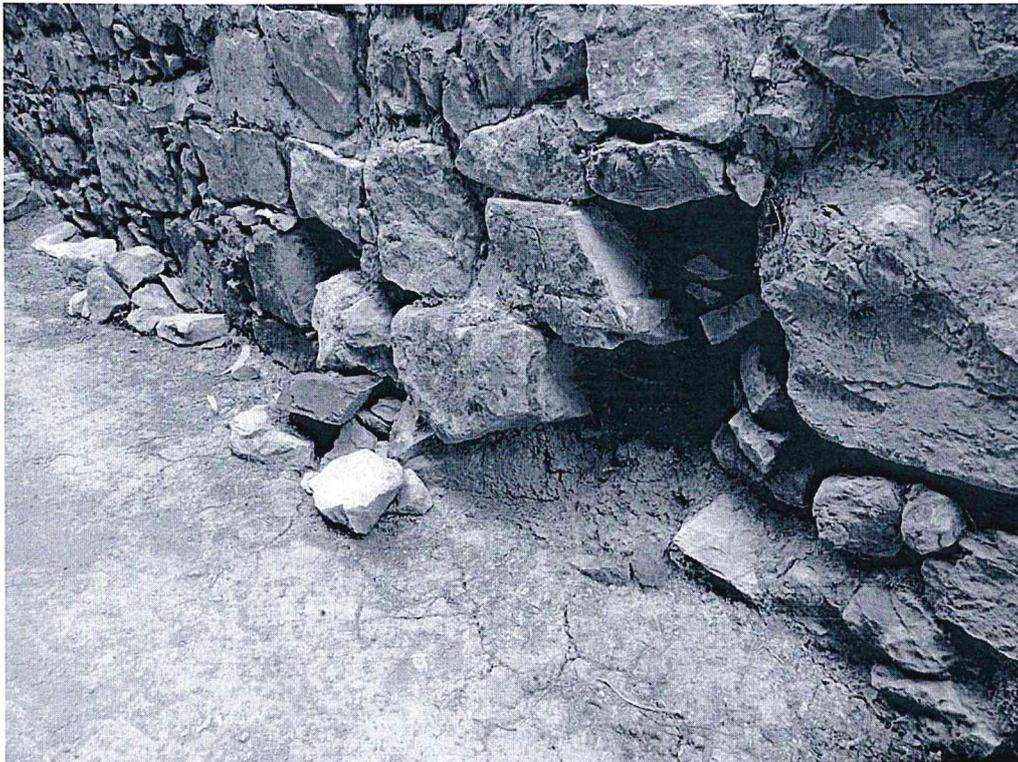
Foto 6, donde se evidencia la erosión de la argamasa de barro y colapso de piedras del muro.
