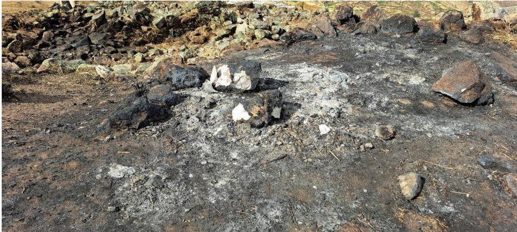
*Imagen 4. Vista a detalle de las rocas de los muros fracturados por la elevación de temperatura producidos por el fuego (Vista S-N).*
