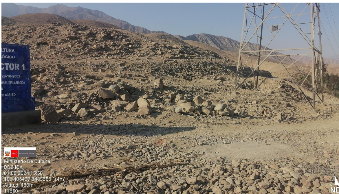
Foto 02. Vista panorámica de estructuras de torre de alta tensión
