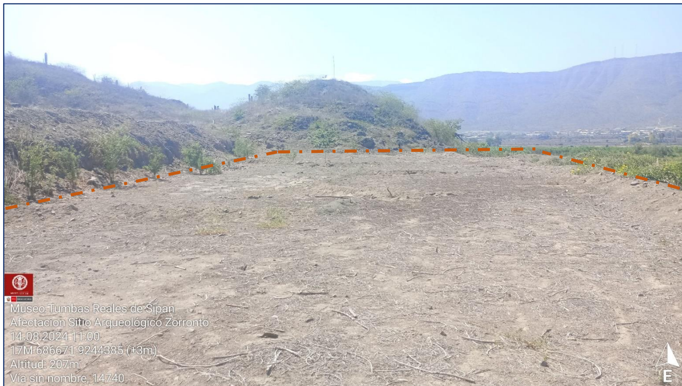
Imagen 03. Fotografía de movimiento de tierras dentro de la poligonal del S.A. Zorronto.
