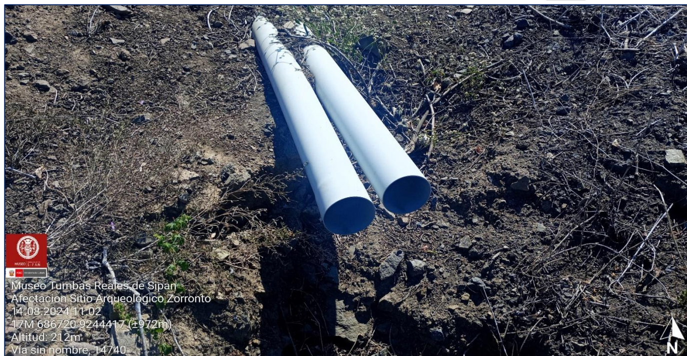
Imagen 05. Fotografía de la tubería de PVC que se ha instalado para riego dentro de la poligonal del sitio arqueológico Zorronto.
