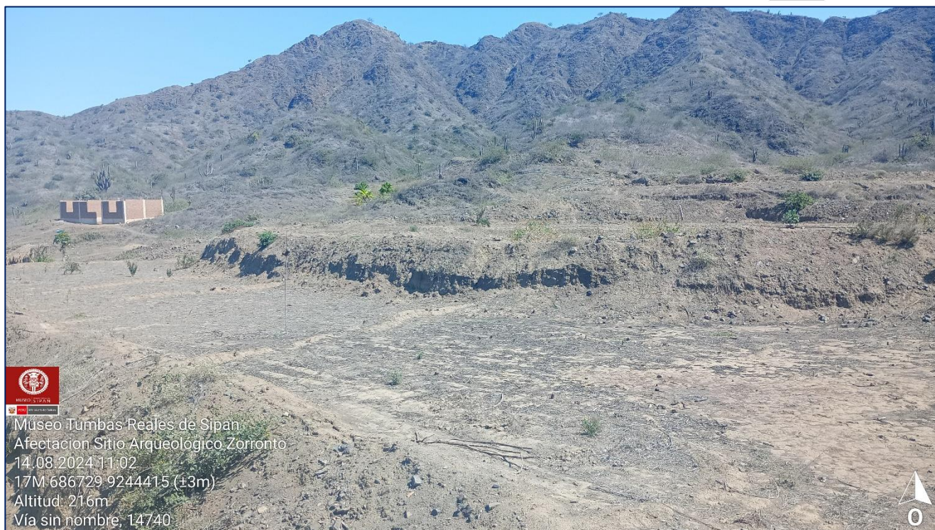
Imagen 07. Fotografía de movimiento de tierras dentro de la poligonal del S.A. Zorronto.
