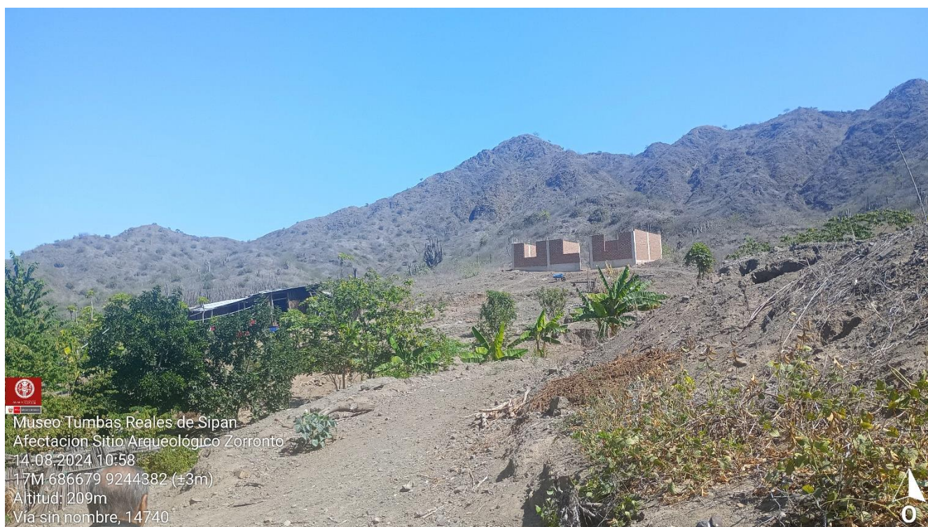
Imagen 10. Afectación de dos (02) casas dentro de la poligonal del sitio arqueológico Zorronto.
