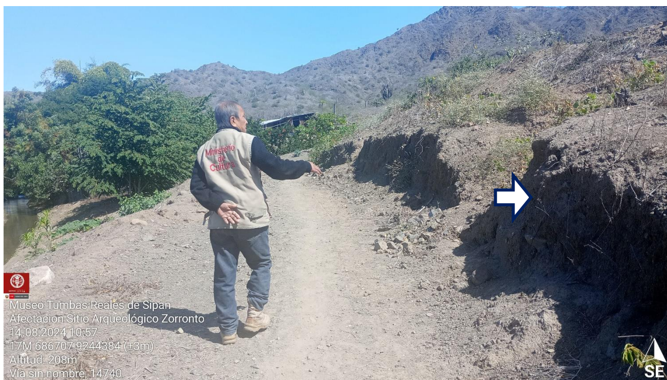
Imagen 08. Fotografía ubicando el movimiento de tierras excavadas con maquinaria pesada.
