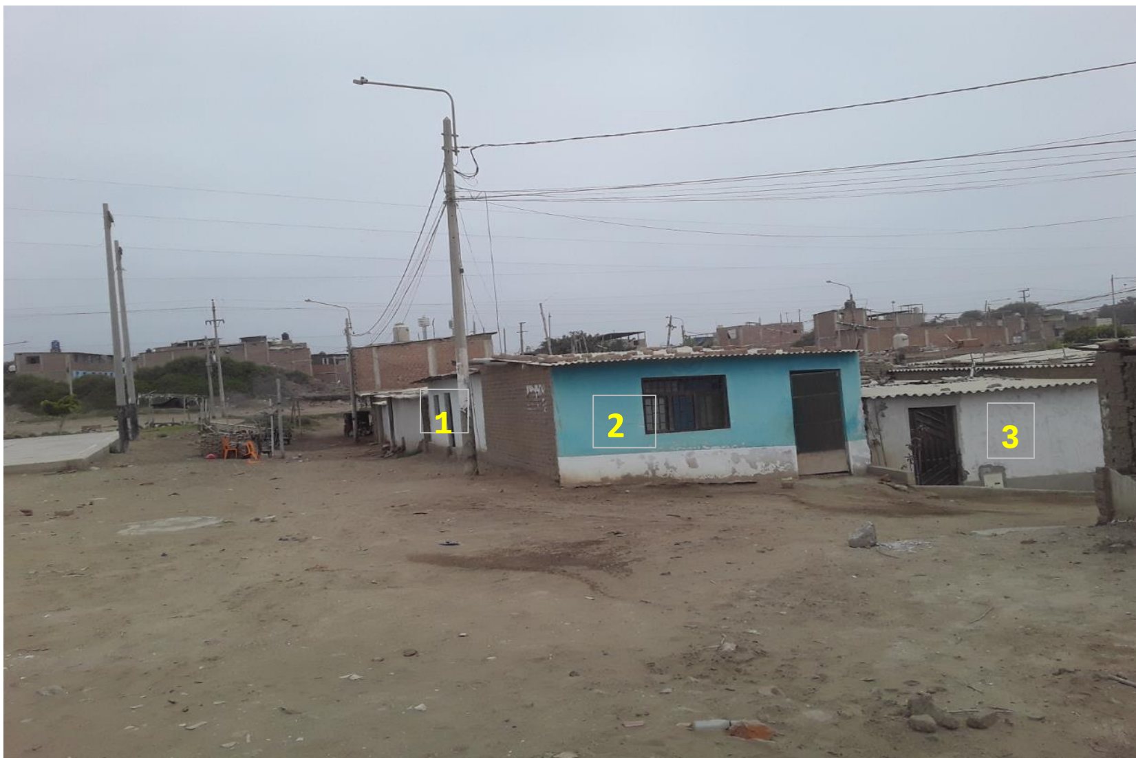
Foto 3: Vista de la afectación 3, se observa la presencia de los tres inmuebles de material rústico ubicados dentro del área intangible del sitio arqueológico Huaca Los Chinos o Huaca Santa Rosa III, lo mismo que persiste desde la protección provisional anterior que ha vencido.
