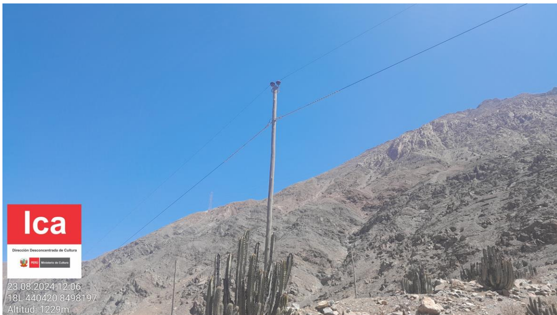
Imagen 04: vista panorámico de la instalación de postes de fluido eléctrico.
