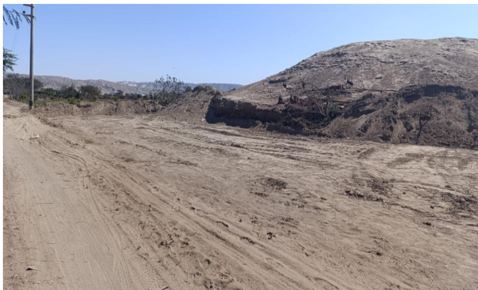
Foto 03. Vista de detalle de la remoción con maquinaria pesada.
