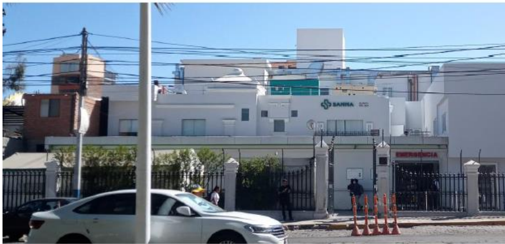
Imagen 3: Toma fotográfica del estado de la fachada del inmueble tras la ejecución de las obras inconsultas.
