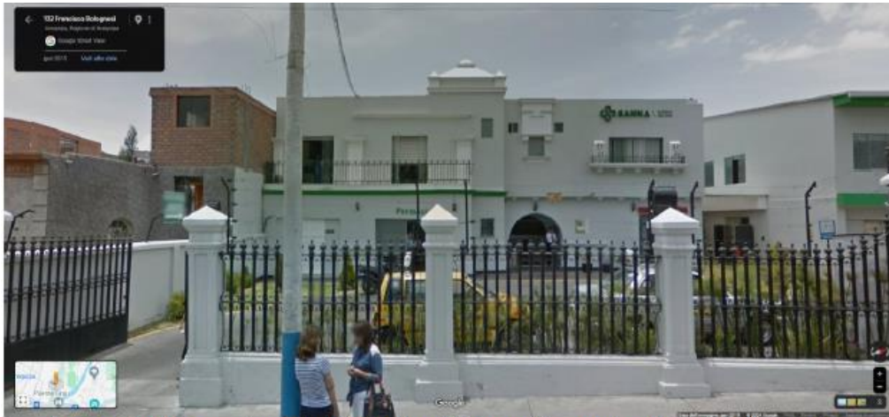
Imagen 2: Vista peatonal de la fachada del inmueble, previa a las obras inconsultas ejecutadas.
