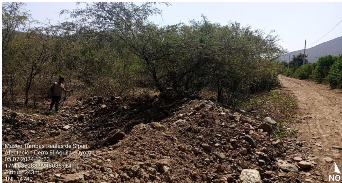
Imagen 04. Fotografía de remoción de tierra, maleza y vegetación arborea.
