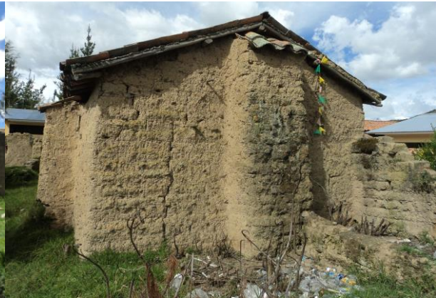
Fachada posterior ( Muro testero)
