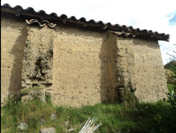
Fachada lateral (Muro de la espístola)
