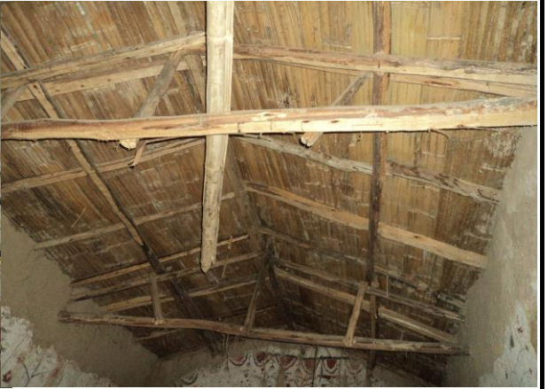
Vista de la estructura de la cobertura
