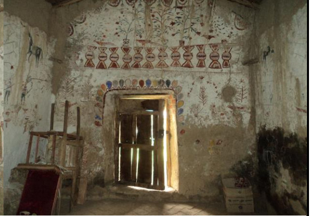
Nave: vista hacia la puerta de ingreso
