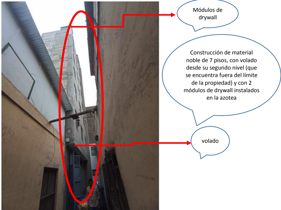
Imagen de la fachada del inmueble ubicado en Jr. Huanta N° 944, Int. D, distrito de Lima.
