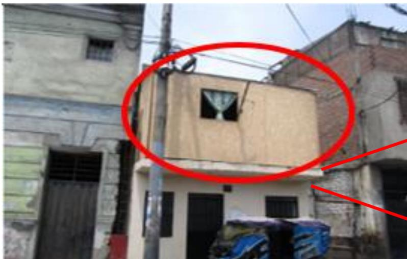
Alero que sobresale del límite de la propiedad, con el cual se alinea la fachada del módulo prefabricado
