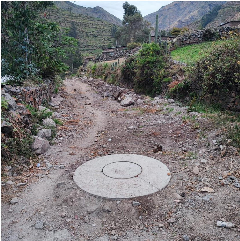
Sitio Arqueológico Gorgorjirca. Nótese la instalación de un buzón para desagüe ubicado a lo largo de la trocha que funciona como vía de acceso colindante al Bien Inmueble Prehispánico ubicado en la parte derecha de la imagen.
