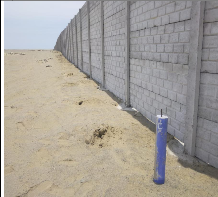
Detalle de muro de material prefabricado nótese las columnas de concreto prefabricado dentro del sitio arqueológico Huaca Colorada, así como empleo de cemento para los cimientos de las columnas. Nótese hito removido y reinstalado dentro del sitio arqueológico Huaca Colorada registro de la inspección de fecha 21 de febrero de 2024.
