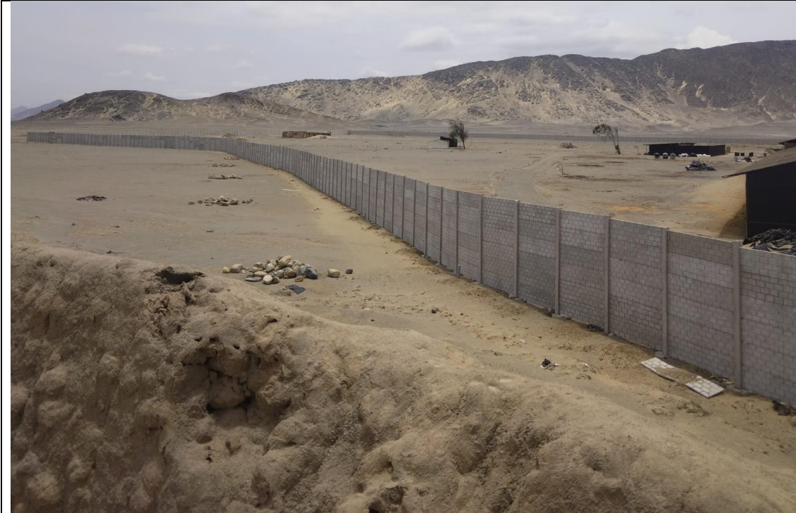
muro de material prefabricado correspondiente a la afectación constatada en el sitio arqueológico Huaca Colorada, el muro se encuentra dentro de la poligonal del mencionado sitio arqueológico.
