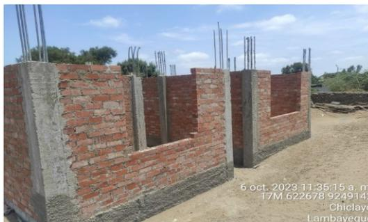
Foto 7 (caso IX). Excavación, remoción, nivelación de suelo, y construcción de una vivienda de material noble (base, columnas y pared de ladrillo rojo).
