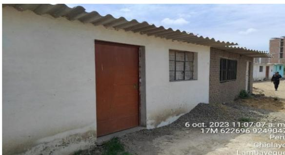
Foto 6 (caso VI y VII). Excavación, remoción, nivelación de suelo, y construcción de dos viviendas de material rustico con argamasa de barro, techo de Eternit, puerta de triplay color marrón y blanco, respectivamente y ventanas de fierro color negro.
