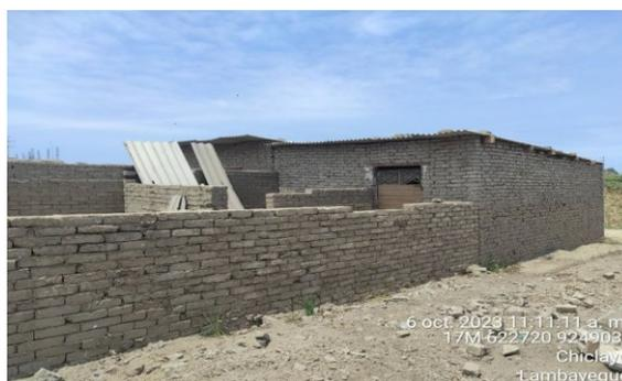
Foto 5 (caso V). Excavación, remoción, nivelación de suelo, y construcción de una vivienda de material rustico con argamasa de barro, enlucido de color blanco, techo de Eternit, puerta de triplay y ventana de fierro color
