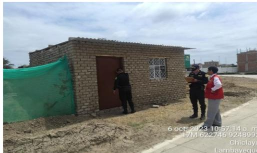
Foto 1 (caso I). Excavación, remoción, nivelación de suelo, y construcción de una vivienda de material rustico con argamasa de barro y techo de Eternit, puerta de triplay y ventana de fierro color blanco.
