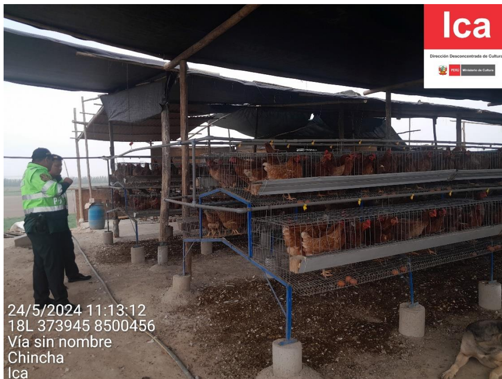
Imagen 03: vista a detalle de los galpones de criadero de pollo, cuya estructura es de material de acero, la misma que presenta techos de palos y malla raschel.
