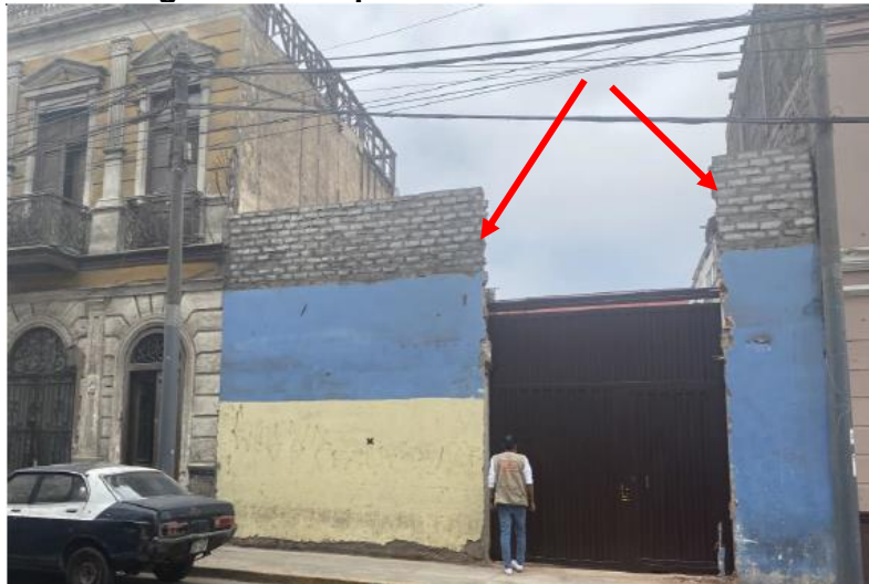
Imagen de la inspección de fecha 10.04.23
