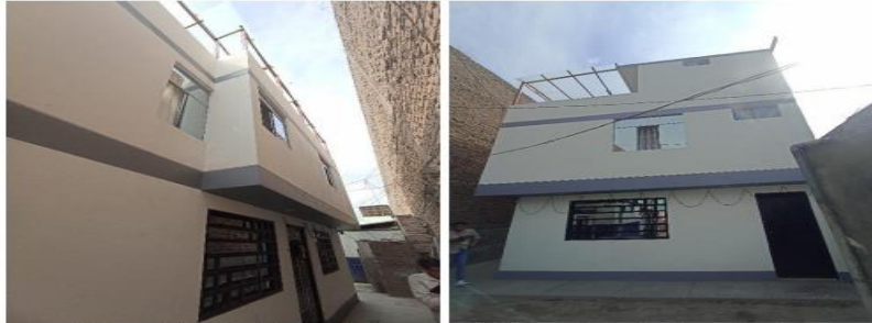
Imágenes del interior 105, 106, donde se aprecia la intervención de dos pisos y la azotea.
