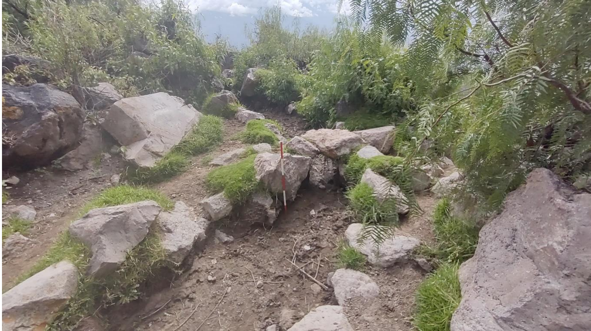
Imagen 13: Canal de agua registrado al lado oeste del Sitio Arqueológico de "Salviapata". Nótese su estado de conservación y material constructivo.
