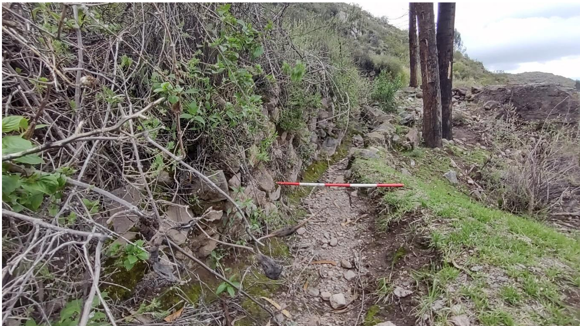
Imagen 10: Canal de regadío registrado junto al muro de un andén en el sector A. Nótese la dimensión de la misma.
