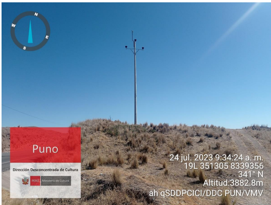
Imagen N° 25: Fotografía panorámica de poste instalado en Sector B.
