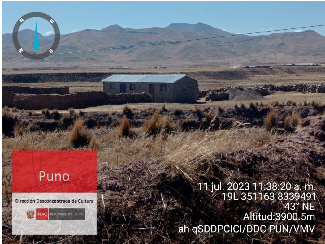
Imagen N° 27: Riesgo por vivienda de material noble edificada en la cima del Sector B, que pueda crecer o ampliarse.
