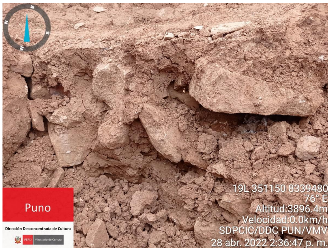
Imagen N° 8: Vista en detalle de relleno constructivo del montículo de Qaluyo en el Sector A, visible por la depredación.
