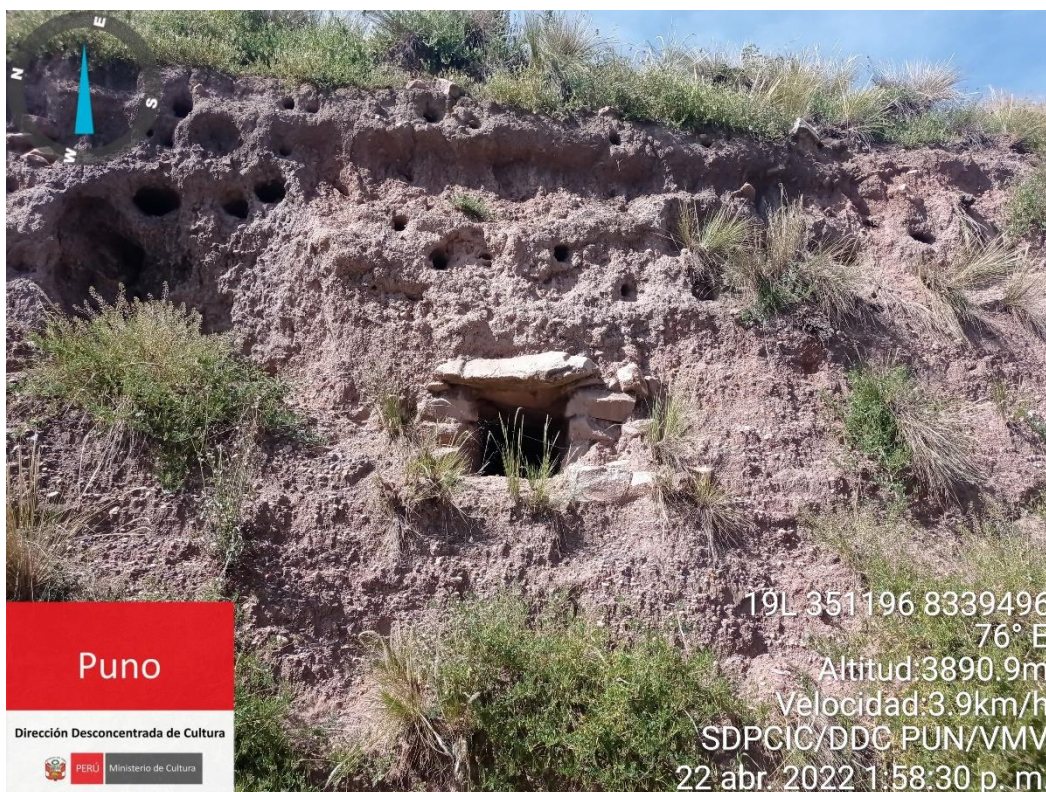
Imagen N° 7: Detalle de ducto de ventilación, en sector B.
