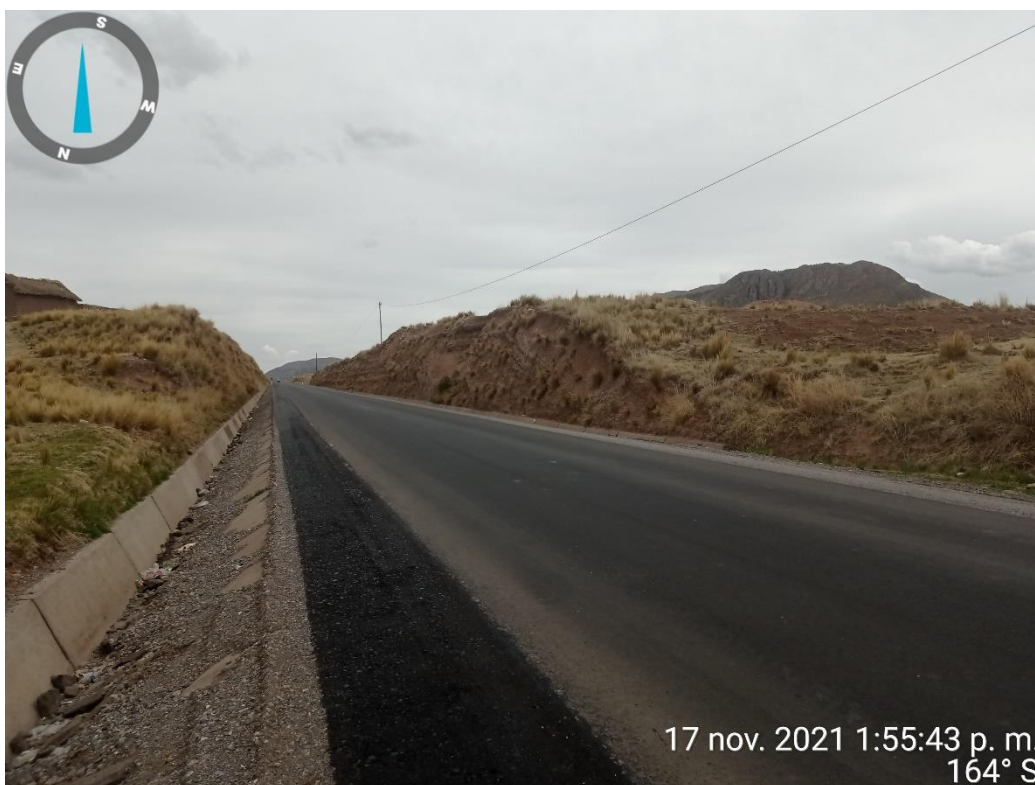
Imagen N° 17: Vista panorámica de la carretera que corta el monumento.
