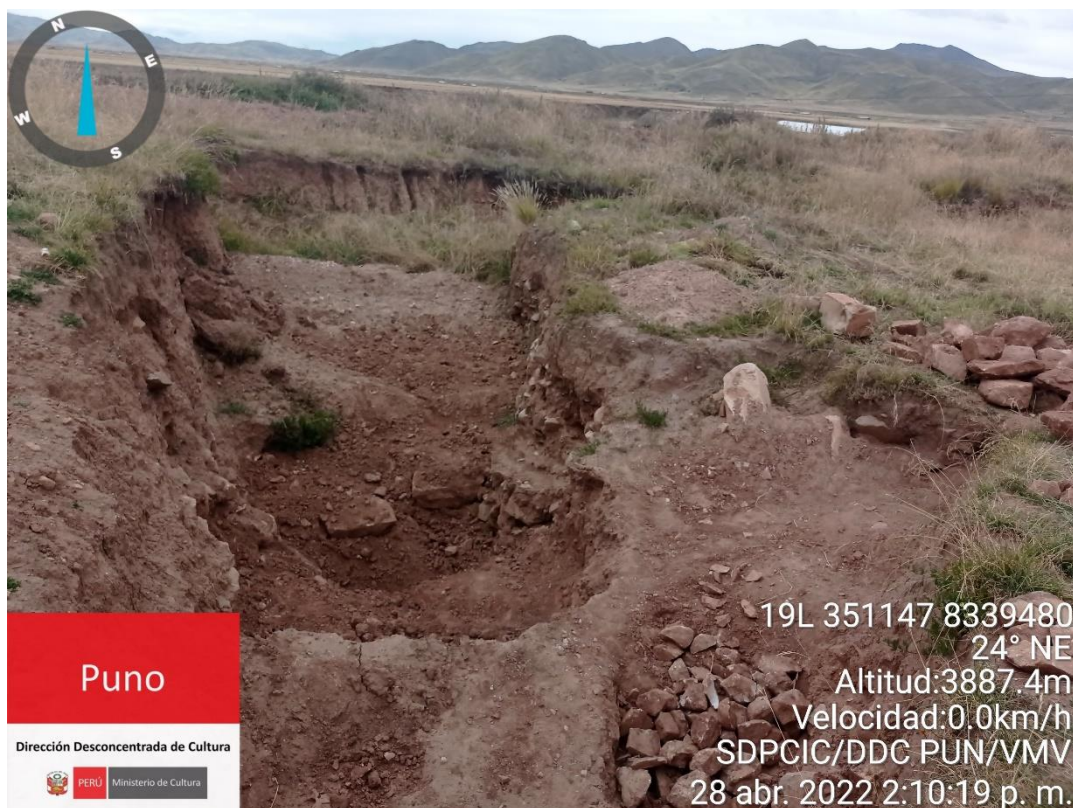
Imagen N° 22: Detalle de deprecación producida en el sector A.
