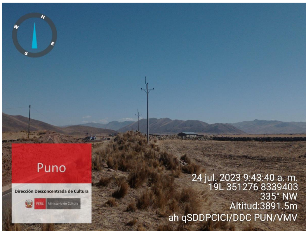
Imagen N° 26: Fotografía panorámica de postes instalados en Sector B.
