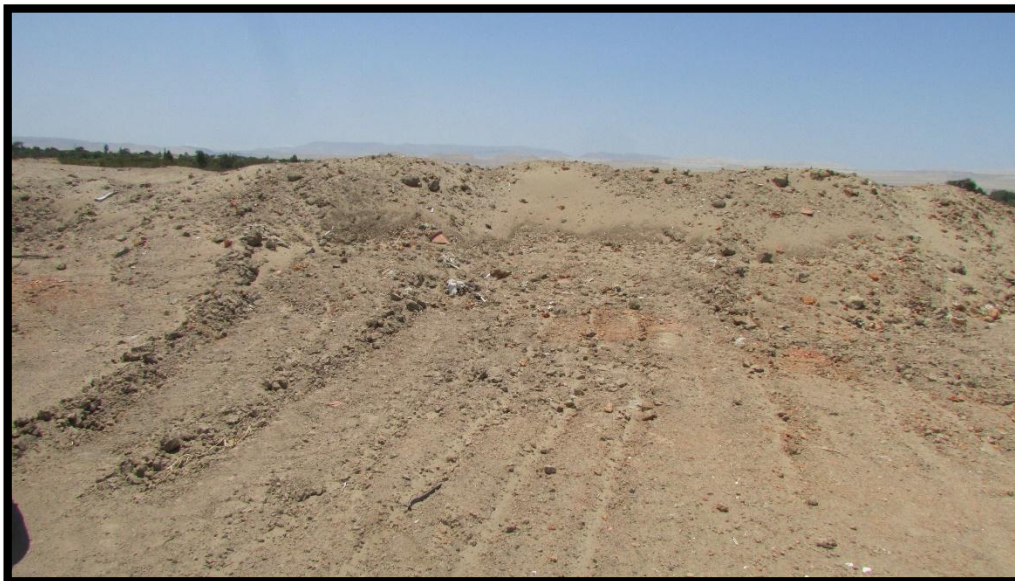
Foto 04. Remoción y excavación de suelo, por parte de maquinaria pesada.
