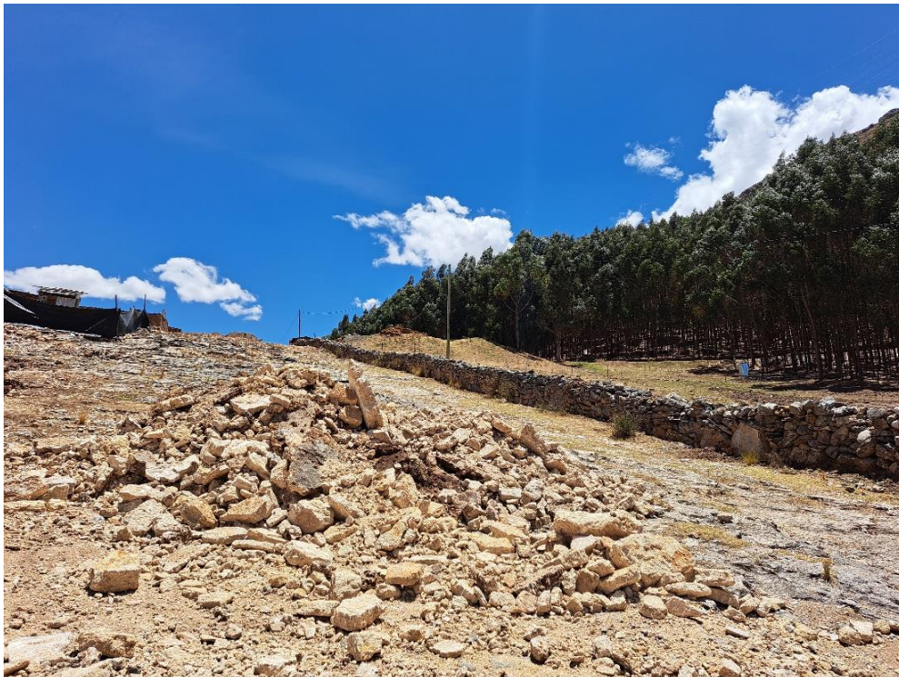
Imagen 8. Área de la calzada del Camino Prehispánico sobre la que han arrojado desmonte (Vista E-O).
