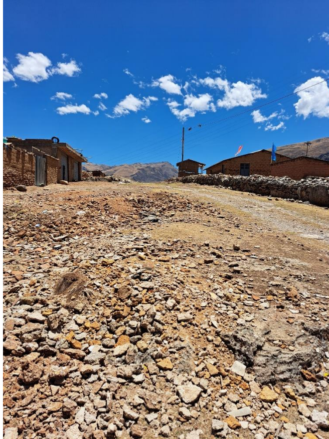
Imagen 11. Desmorte sobre la calzada del Camino Prehispánico (Vista O-E).
