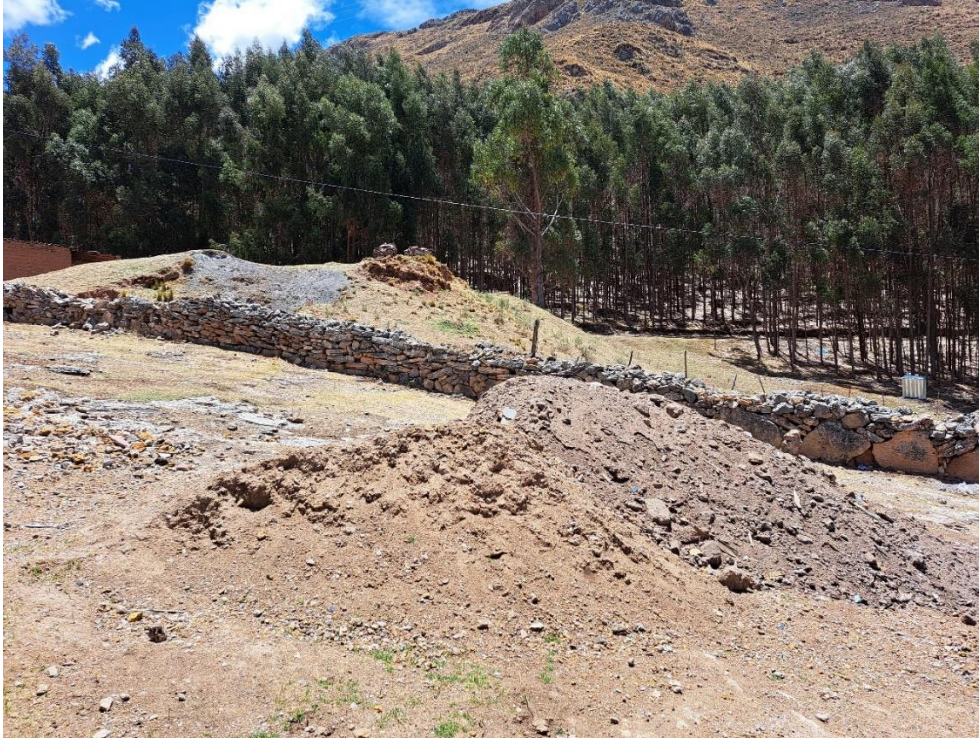
Imagen 9. Desmonte arrojado sobre la calzada del Camino Prehispánico (Vista S-N).
