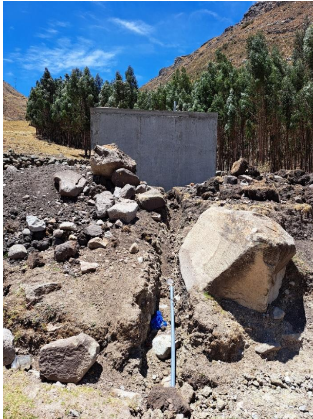
Imagen 6. Excavaciones realizadas para las instalaciones de tubería (Vista S-N).
