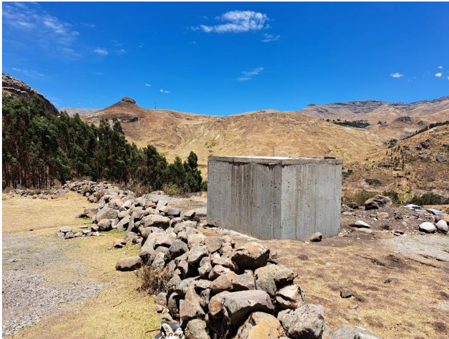
Imagen 4. En el Camino Prehispánico Tramo Comunidad Campesina San Cristóbal Sector 2, vista de la construcción de un reservorio de agua al interior del polígono propuesto (Vista NO-NE).
