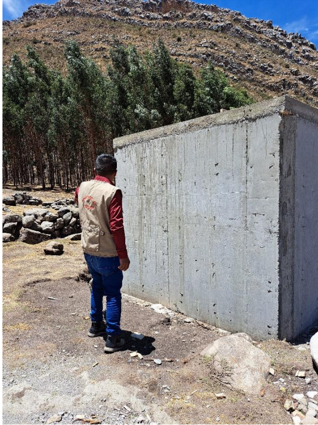
Imagen 5. Inspección realizada por el equipo de Subdirección al Camino Prehispánico Tramo Comunidad Campesina San Cristóbal Sector 2, en la zona de construcción del reservorio de agua (NO-SE).
