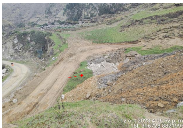
Imagen 09: Vista de la presunta afectación del depósito de materiales (DME) que la obra usó. Nótese superposición con trazo de camino prehispánico.
