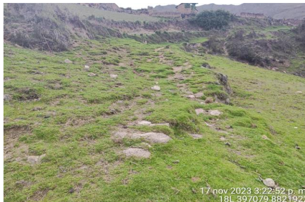
Imagen 07. Vista de una sección del segmento de camino de Chipa. Nótese calzada con empedrados.
