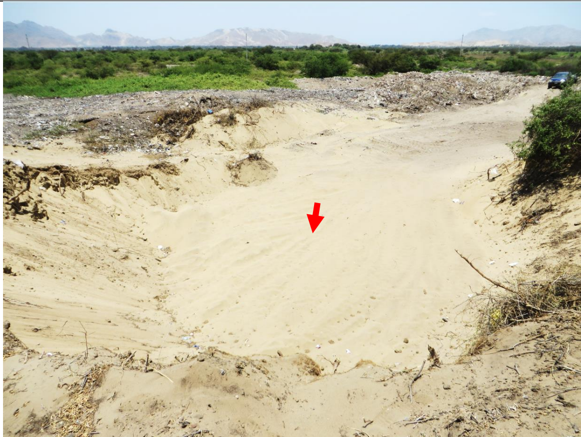
Imagen 10: Vista panorámica del socavón (noreste - suroeste).
