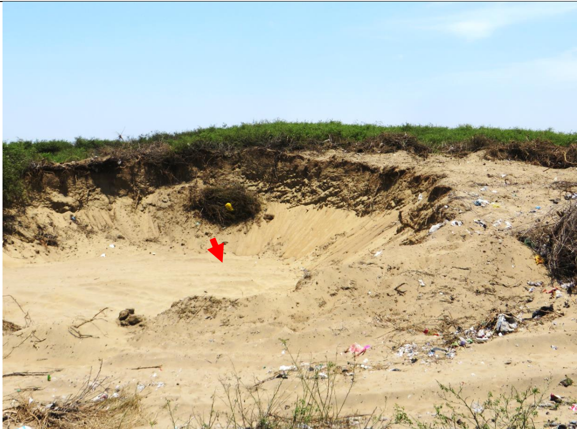
Imagen 11: Vista panorámica del socavón (sur - norte).
