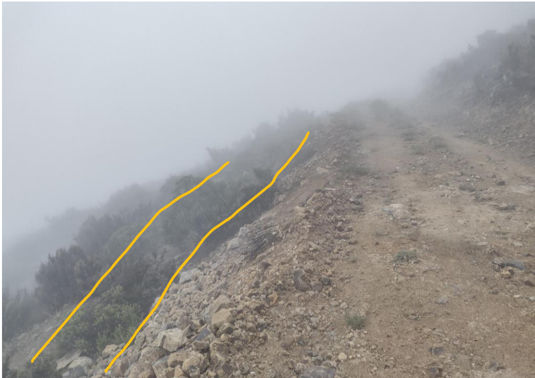
Foto 3: trocha carrozable y segmento de camino pedestre en abandono con plantas crecidas.
