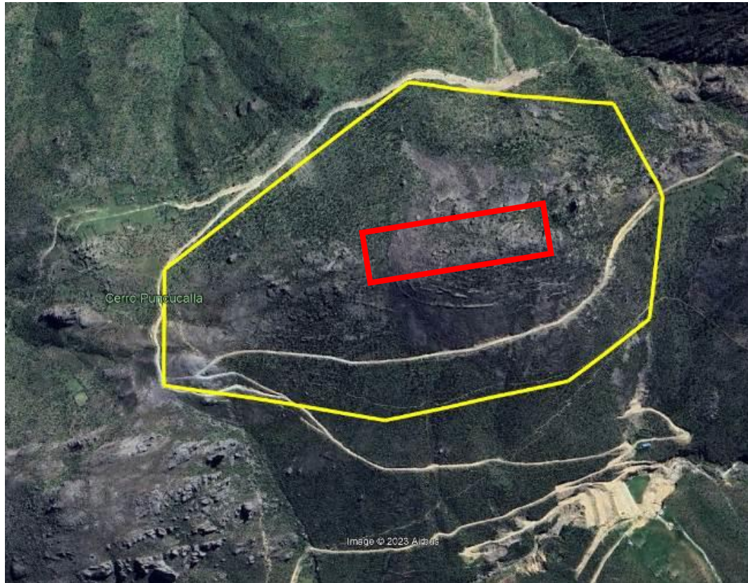
Foto 1: propuesta de polígono para el sitio arqueológico Puncucalla. Se observa la trocha carrozable construida sobre el trazo del camino pedestre. En el rectángulo de color rojo se puede observar el segmento de camino que no ha sido alterado por la construcción de la trocha.
