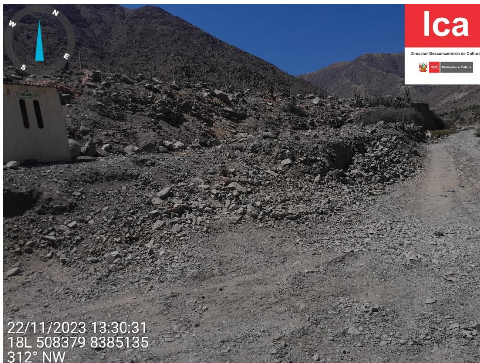
Imagen 08: vista panorámica de la remoción del suelo para un camino carrozable por medio de una quebrada seca.
