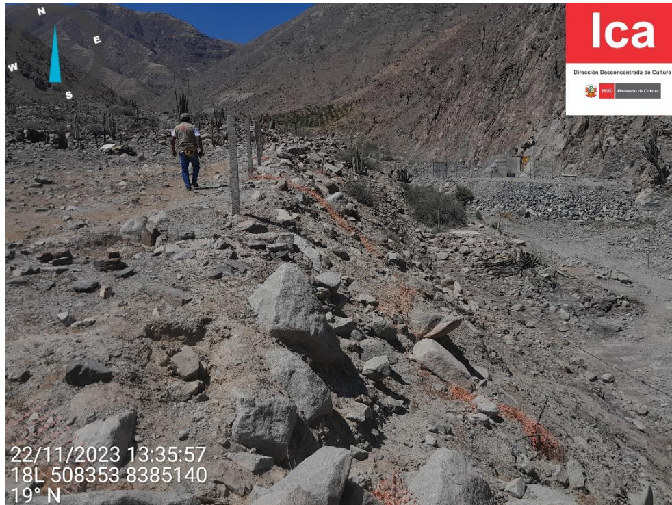
Imagen 07: vista panorámica de la instalación de postes de cemento y malla de polietileno, cuya afectación es directamente a los restos arquitectónicos.
