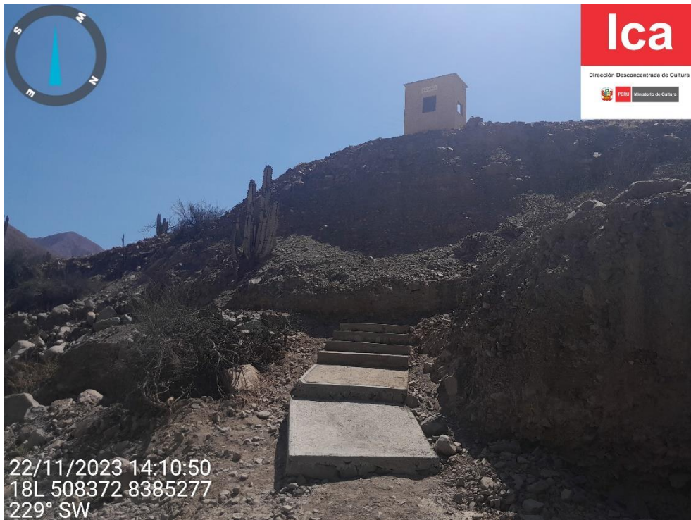
Imagen 06: vista panorámica de un acceso peatonal con material de concreto, y en cima del lugar se observa la caseta de seguridad.
