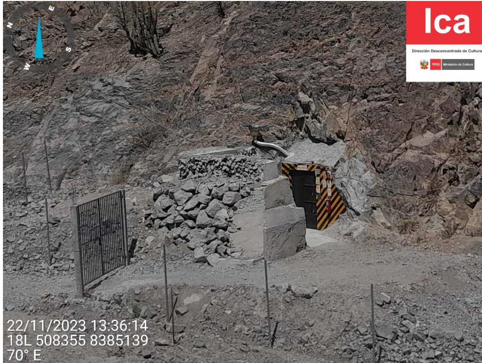
Imagen 12: vista panorámica del ingreso al polvorín 01; a la vez se observa el cerco perimétrico con malla metálica al contorno de dicha planta.
