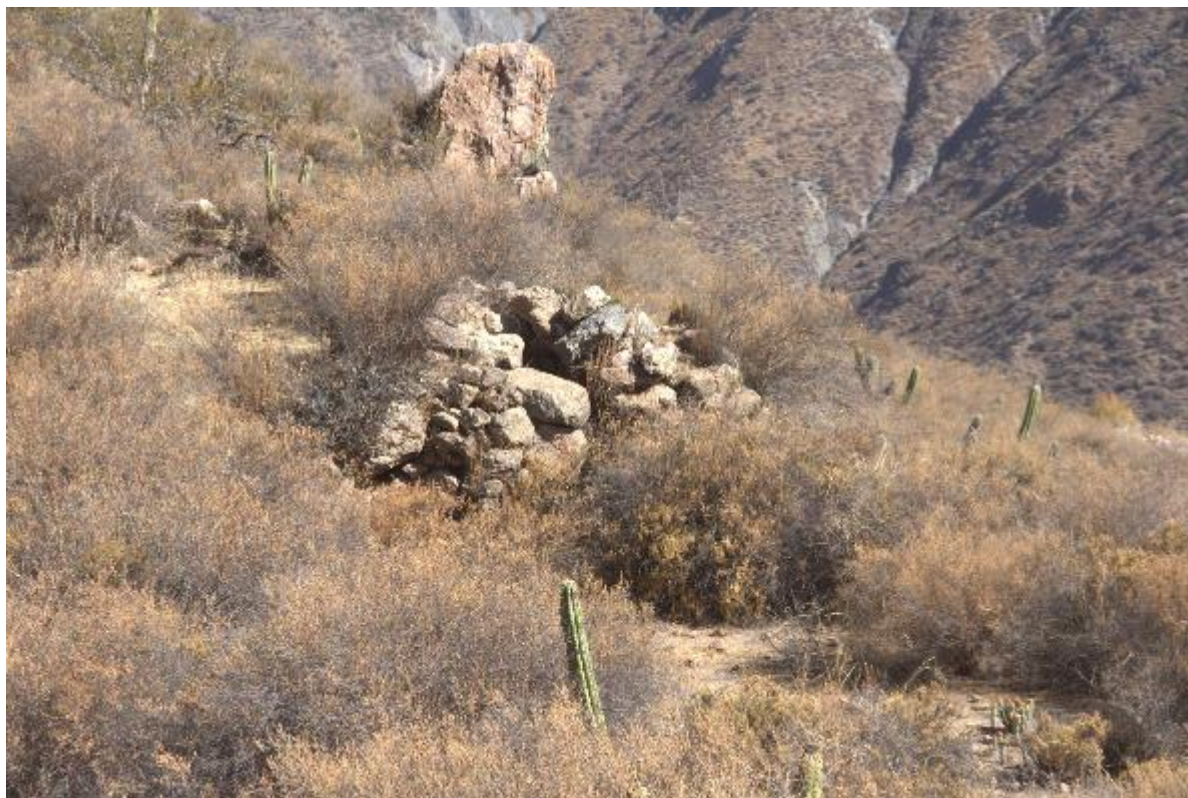
Imagen 11: Estructura funeraria huaqueada. Nótese el techo y acceso colapsados.
