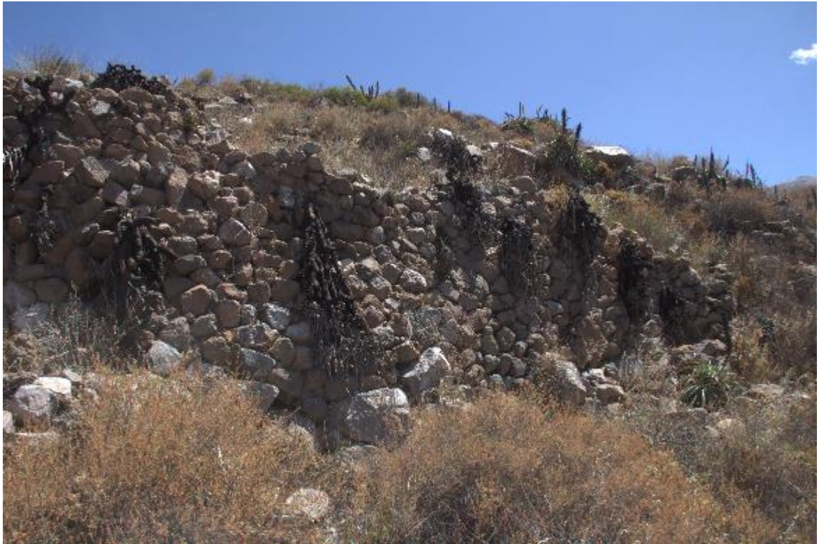
Imagen 13: Muro de contención de grandes dimensiones sobre los cuales se ha construido estructuras circulares.
