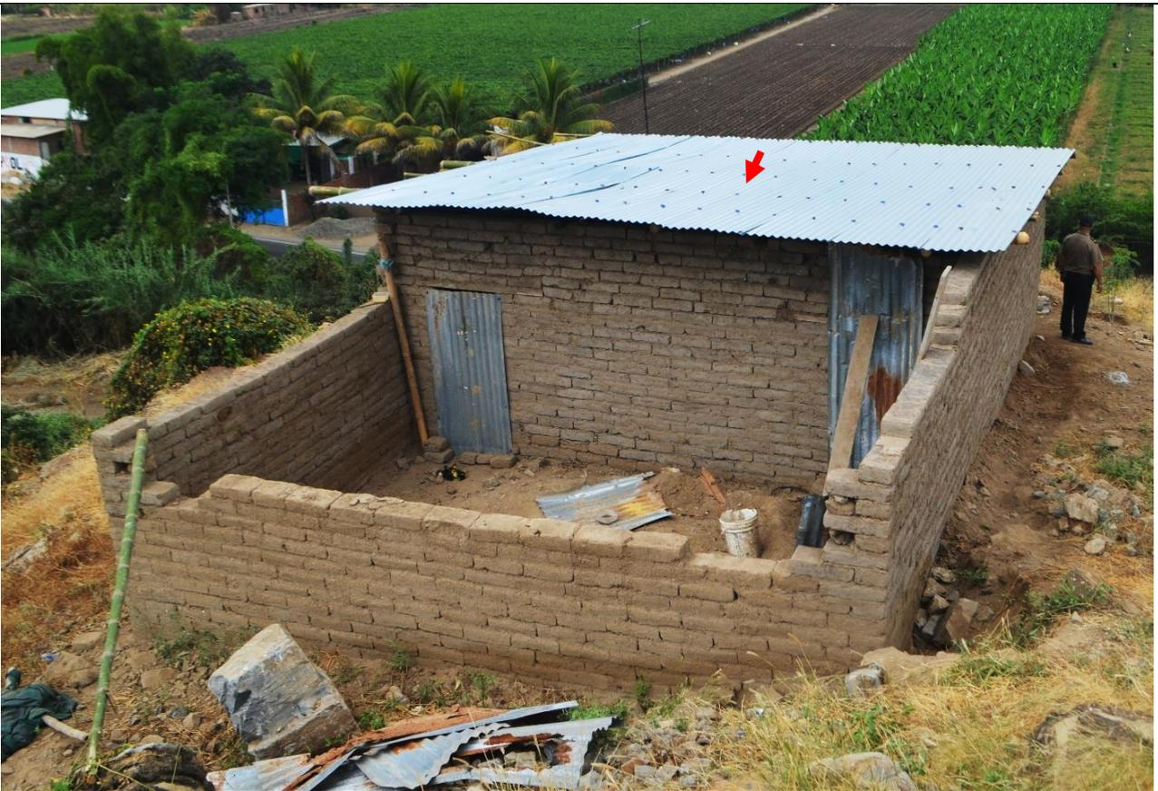
Imagen 6: Vista de la casa de adobe en proceso de construcción (al momento de la inspección).
