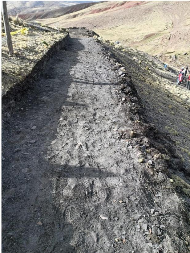
*Fotografía 18. Vista de las excavaciones manuales realizadas para la construcción de accesos al Paisaje Arqueológico salar de Qarawanka (Vista S-N).*
