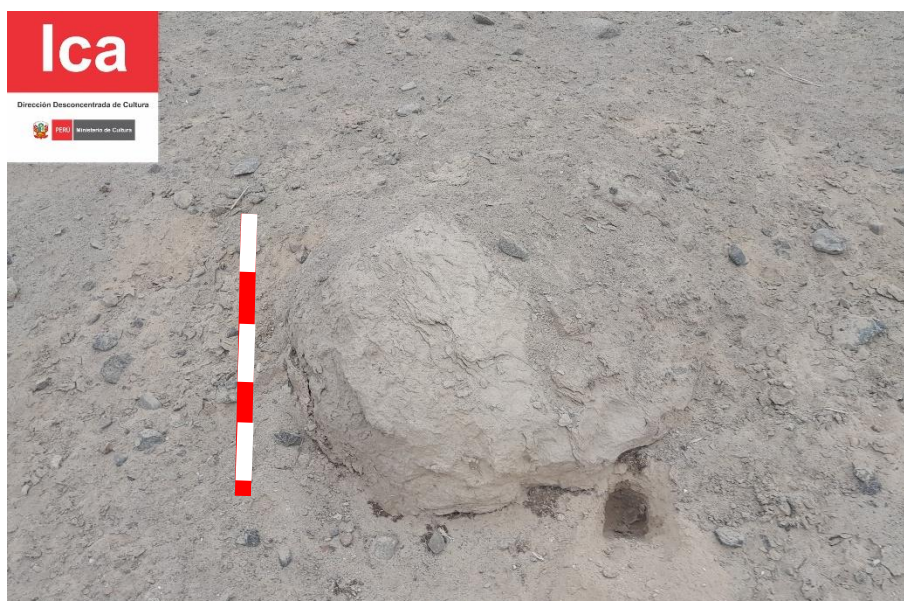
Foto N° 03: vista a detalle de la cabecera de un muro de adobe.
