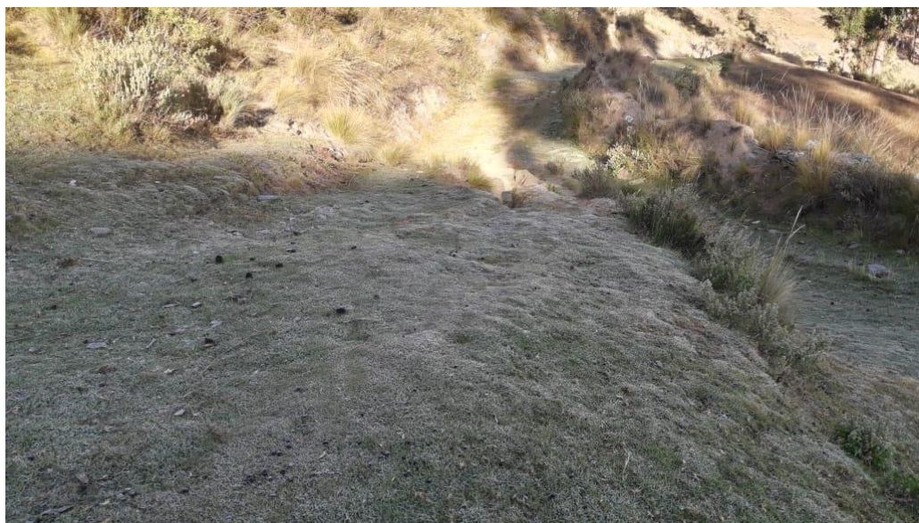
Fig. 05. Vista del camino prehispánico se puede ver la calzada. El camino se encuentra en partes en buen estado y en otras en mal estado.
