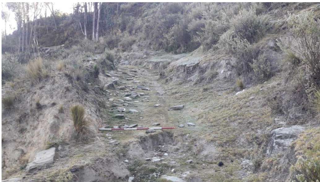
Fig. 04. Vista del camino prehispánico se puede ver la calzada desgastada por el constante transito sin mantenimiento.
