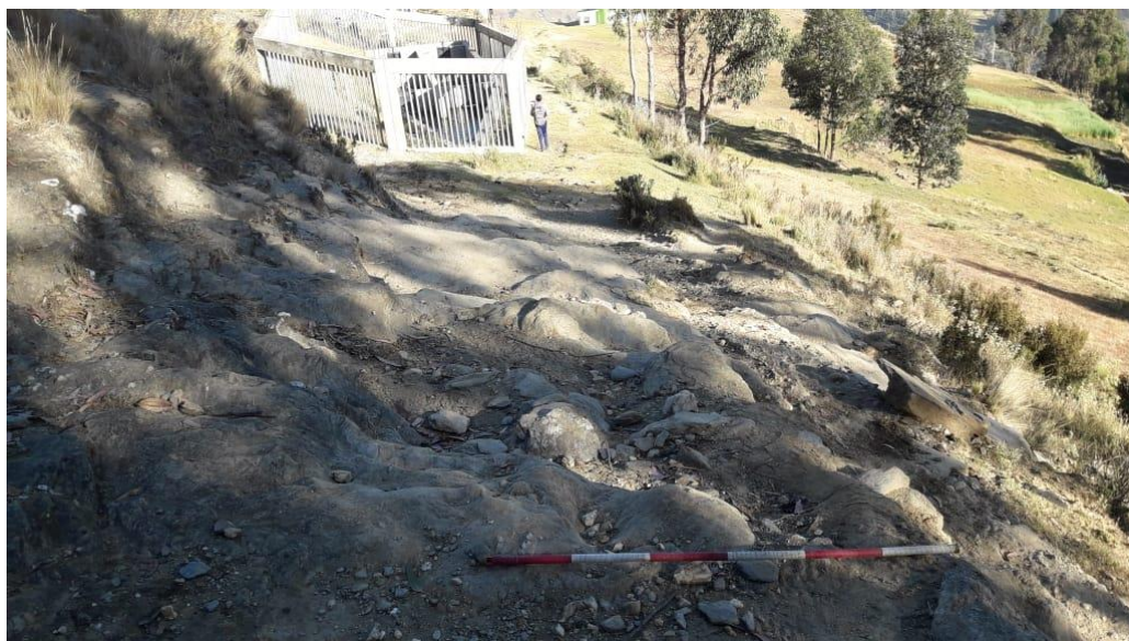
Fig. 08. Vista del camino prehispánico se puede ver la afectación de parte de un reservorio de agua de la Municipalidad Provincial de Yarowilca.
