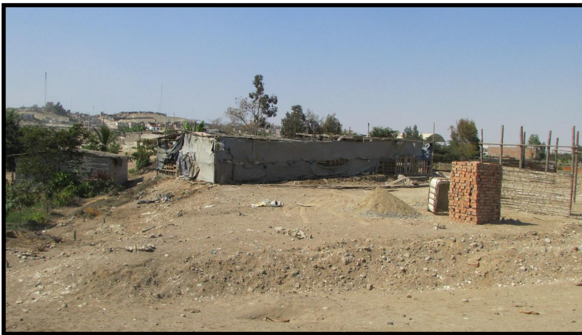
Figura 09. Estructuras temporales construidas dentro del sitio arqueológico, así mismo se observa la intención de construir en un futuro con material noble.
