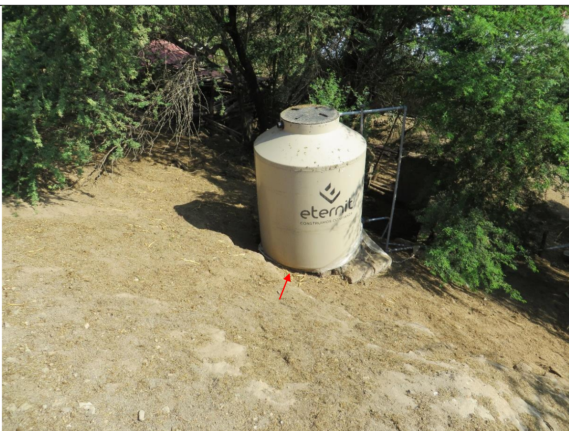
Imagen 6: Vista de la cisterna para agua potable.
