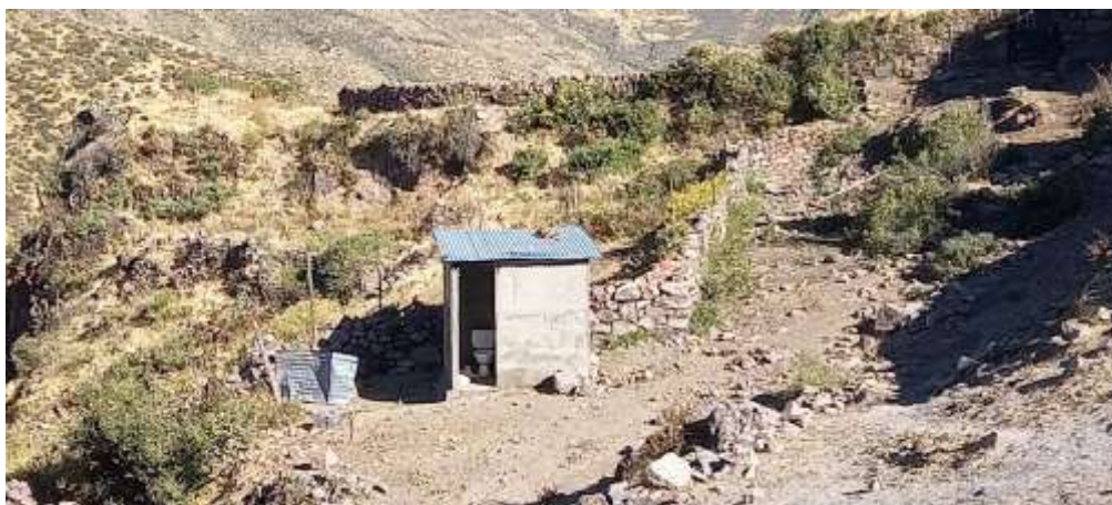
Foto 03: vista de la estructura de material noble para ser empleada como baño al interior del Sitio Arqueológico Arcopunku, ubicado en el distrito de San Lorenzo de Quinti, provincia de Huarochirí, departamento de Lima.
