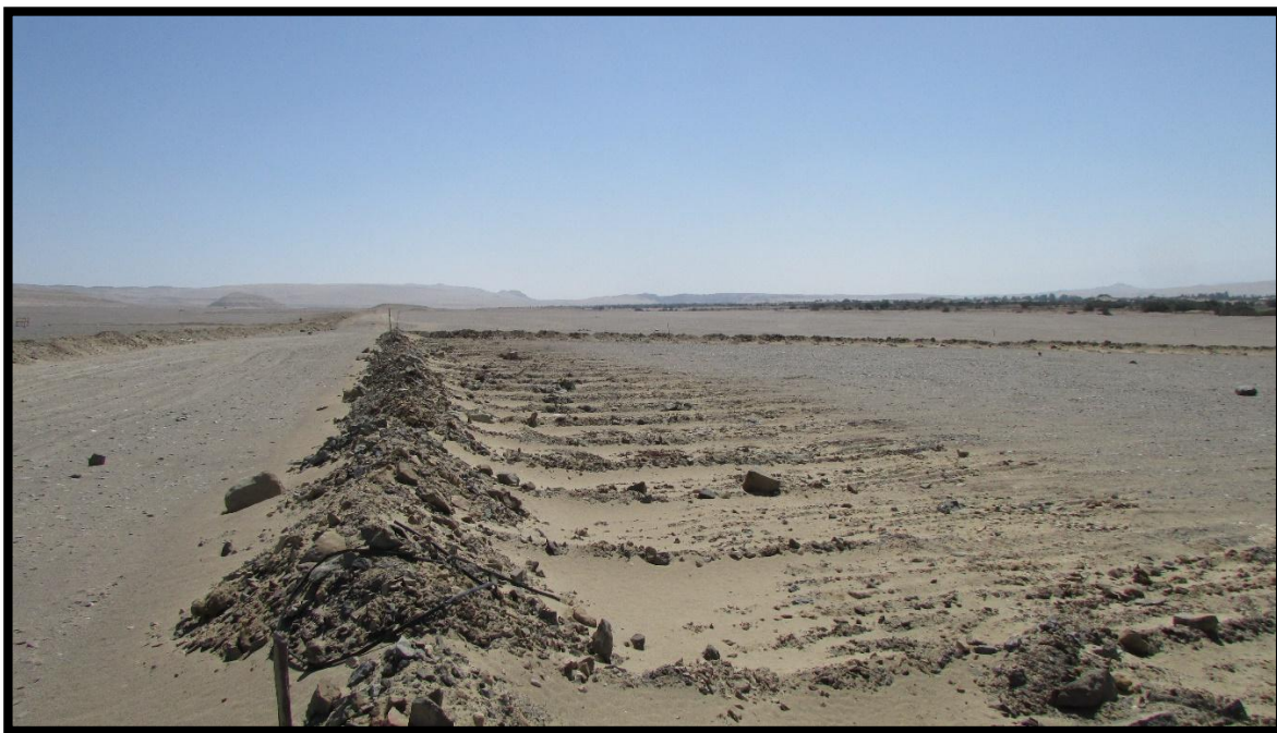
Figura 08. Remoción de tierra con maquinaria pesada, dentro del área de concentración de geoglifos.
